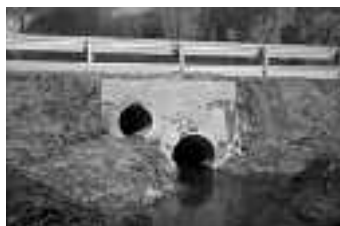
Exemples d’ouvrages, de diverses tailles, aménagés pour le passage de la loutre et de la “petite faune”
